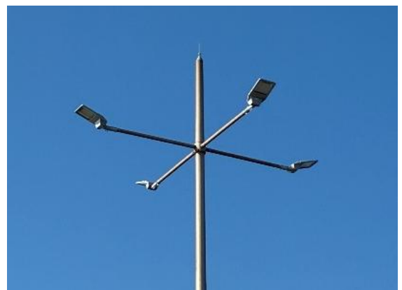
取替後：LED（岸壁照明）
