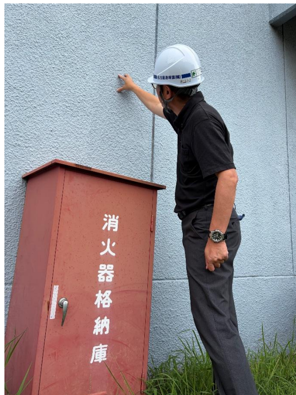
○建物の状況を確認
